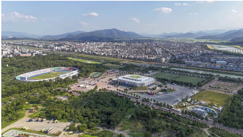
▲경주 황성공원 일원에 위치한 경주시민운동장과 축구공원 전경. 경주시는 노후 체육시설 정비를 통해 안전하고 쾌적한 생활체육 환경 조성에 나선다. 제공=경주시
